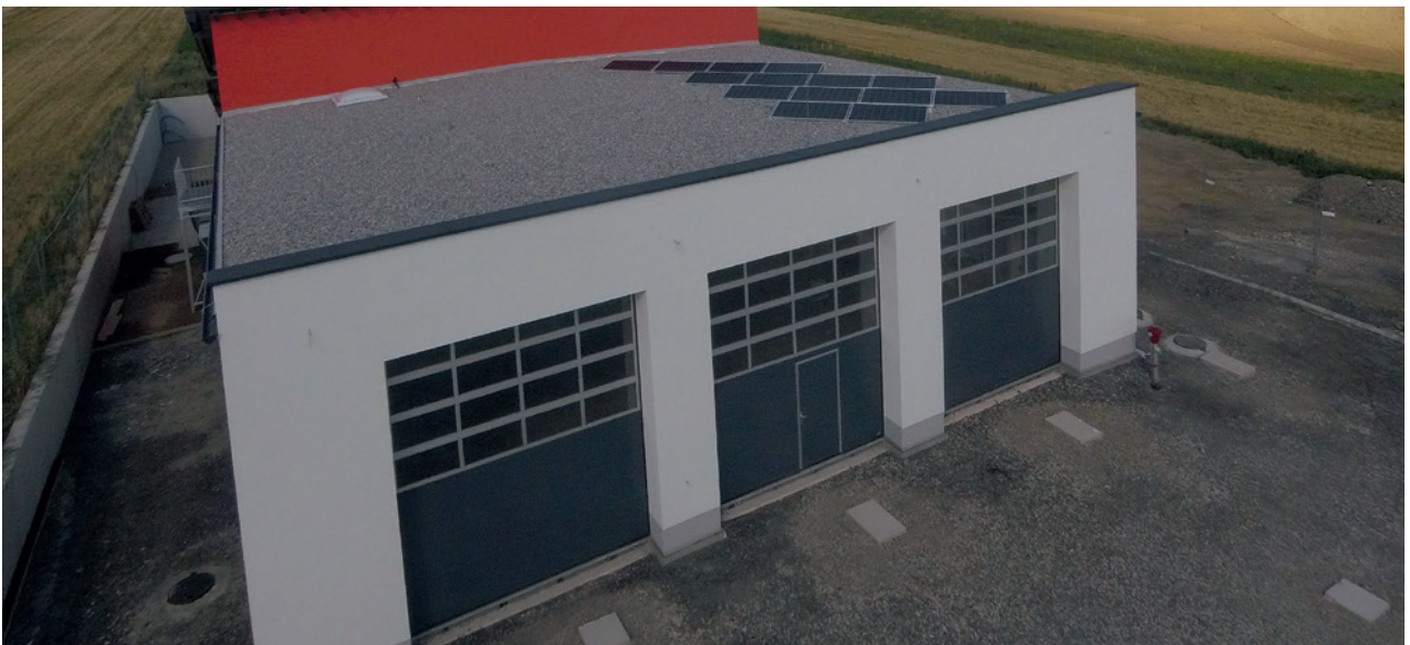
Die PV Anlage in Ost- West Ausrichtung mit 9,24 kWp
