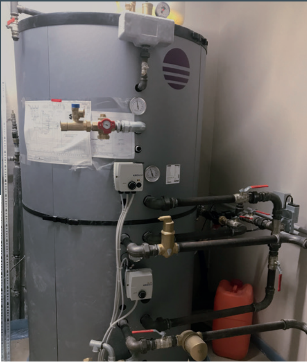
Der Systemspeicher EMMA mit integriertem Edelstahl-Wellrohrregister für hygienische TWW-Bereitung.
