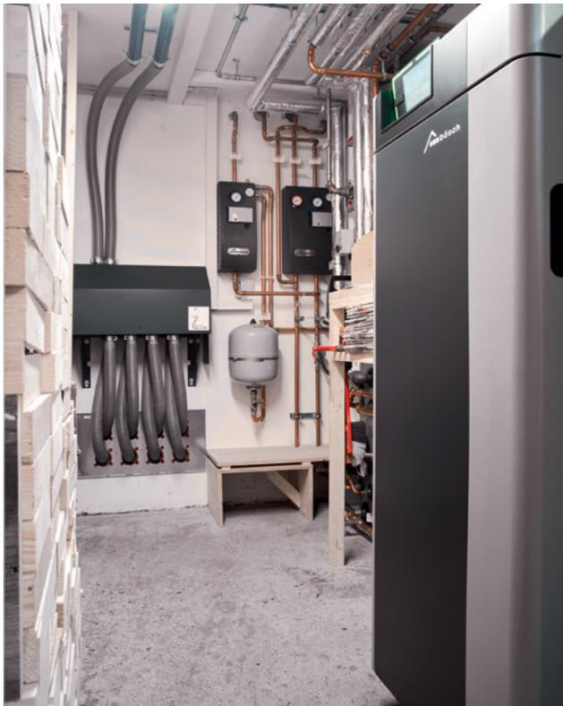
Der ehemalige Öltankraum wurde zum Pelletlager umfunktioniert. Über ein Absaugsystem mit vier Sonden wird der Brennstoff zum Kessel transportiert.
