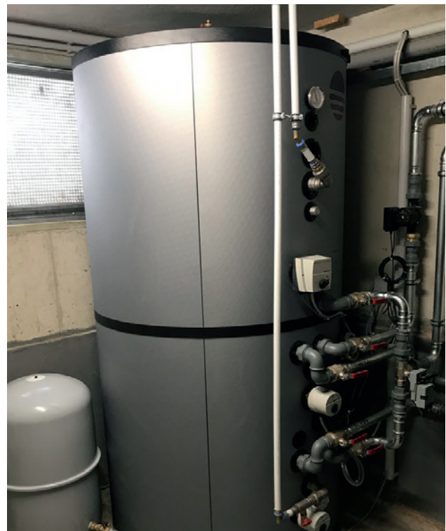
Der Systemspeicher EMMA mit integriertem Edelstahl-Wellrohrregister für hygienische TWW-Bereitung und optimales Wärmemanagement.
