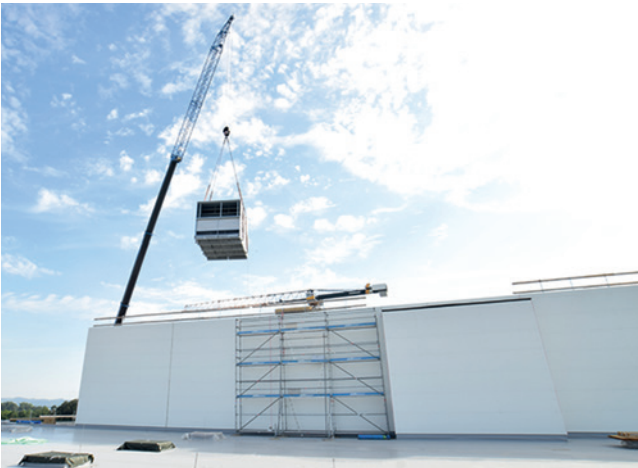
Die Anlieferung von drei Lüftungsgeräten in Kuben mit dem Schwerlasttransport.
