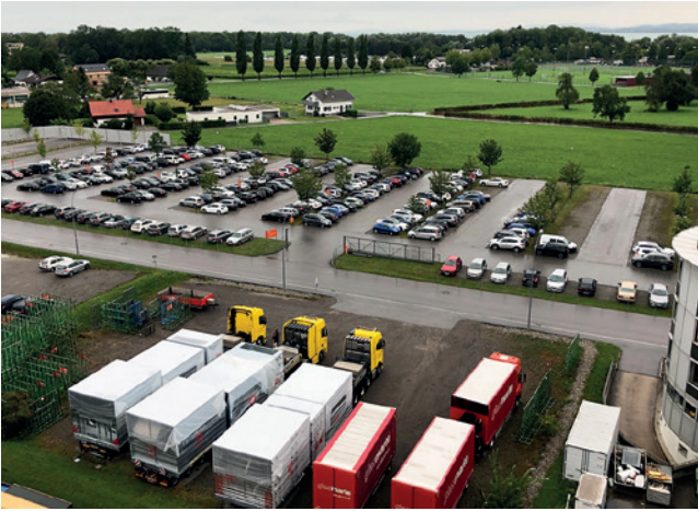
Die Anlieferung von drei Lüftungsgeräten in Kuben mit dem Schwerlasttransport.
