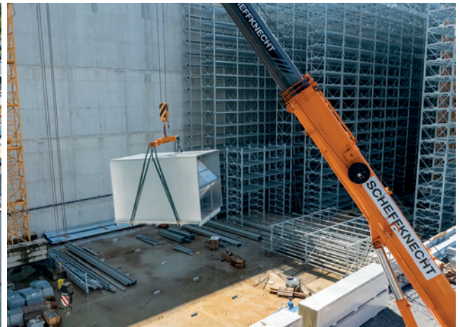
Der Verhub der Kuben mit einem Kran direkt durch das Dach in den obersten Stock.
