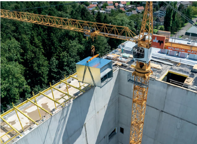
Der Verhub der Kuben mit einem Kran direkt durch das Dach in den obersten Stock.
