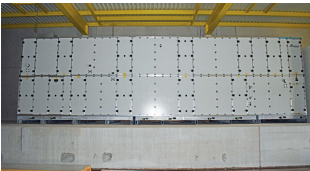
Eines der fertigen Lüftungsgeräte.
