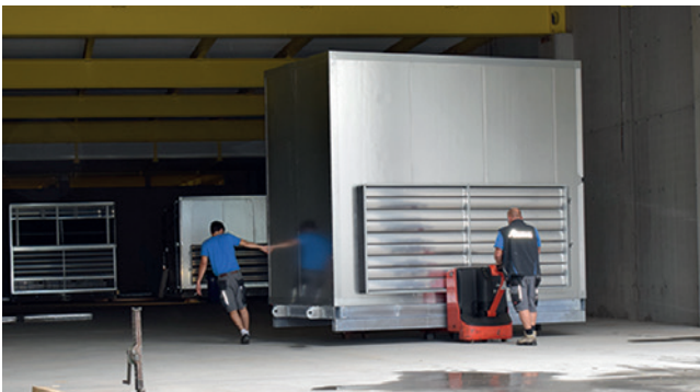
Nach dem Verhub werden die Kuben an die richtige Position transportiert und montiert.
