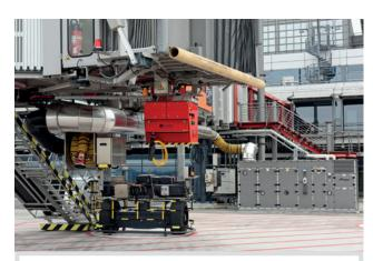
Bei jeder Fluggastbrücke ist ein entsprechendes Lüftungsgerät fix installiert. Die Geräte wurden in den Kategorien D und E ausgeliefert.
