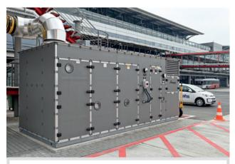
15 PCA-Geräte sorgen auf dem Hauptvorfeld für die effiziente und geräuscharme Belüftung der Flugzeugkabinen.
