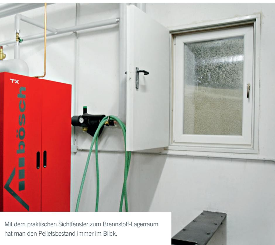
Mit dem praktischen Sichtfenster zum Brennstoff-Lagerraum hat man den Pelletsbestand immer im Blick.
