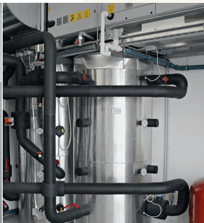
Der Kältespeicher im Technikraum der Bank verwaltet die Wärmezufuhr der Wärmepumpen.
