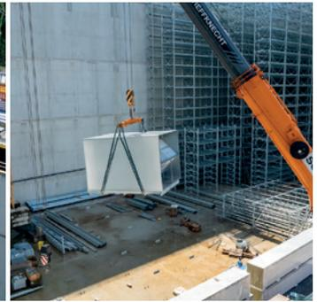
Der Verhub der Kuben mit einem Kran direkt durch das Dach in den obersten Stock.
