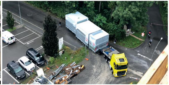
Die Anlieferung von drei Lüftungsgeräten in Kuben mit dem Schwerlasttransport.
