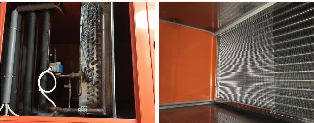
Statt mit Kältemittel betriebene Direktverdampfer (links) sind nun energiesparende und umweltschonende, weil mit wasserbetriebene, Kühlregister im Einsatz
