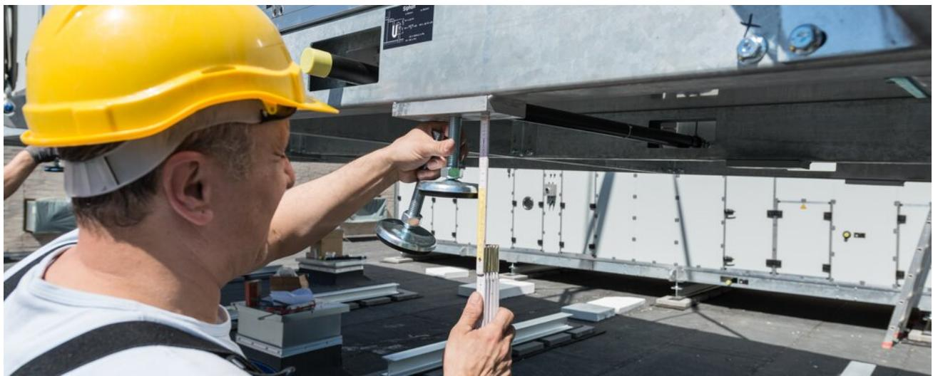
Die bösch Geräte sind durchdacht bis ins Detail: Die verstellbaren Füße ermöglichen das zentimetergenaue Nivellieren des Gerätes auch auf unebenen Flächen.
