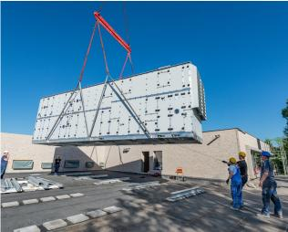
Die tonnenschweren Lüftungsgeräte wurden im Werk in Lustenau/Österreich gefertigt und per Sondertransport nach Werne befördert. Beim Verladen aus der Werkshalle auf den Lkw war Maßarbeit gefragt. Sieben Tonnen wiegt das wetterfeste Gerät für Umkleide und Nebenräume, welches in Werne per Auslegerkran vom 50 Meter entfernten Parkplatz auf das Dach gehievt wurde.
