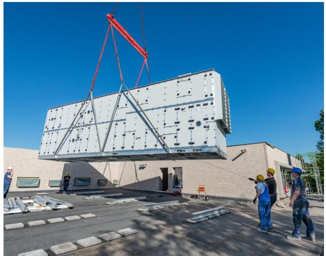
Die tonnenschweren Lüftungsgeräte wurden im Werk in Lustenau/Österreich gefertigt und per Sondertransport nach Werne befördert. Beim Verladen aus der Werkshalle auf den Lkw war Maßarbeit gefragt. Sieben Tonnen wiegt das witterfeste Gerät für Umkleide und Nebenräume, welches in Werne per Auslegerkran vom 50 Meter entfernten Parkplatz auf das Dach gehievtt wurde.
