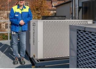
Mischluftgerät mit aufgesetzter zweistufiger adiabater Kühlung
