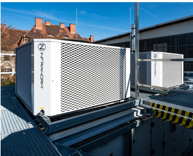
Mischluftgerät mit aufgesetzter zweistufiger adiabater Kühlung
