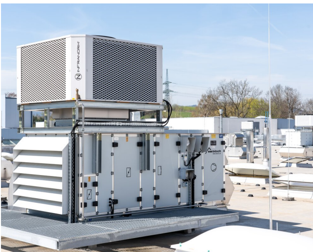
Mischluftgerät mit aufgesetzter zweistufiger adiabater Kühlung
